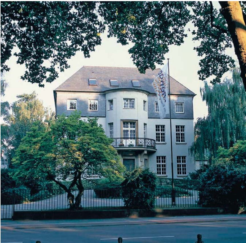
Traditionsreiches Gebäude, 140-jährige Erfahrung, modernes Rechenzentrum: Die Rhenag in Köln.
